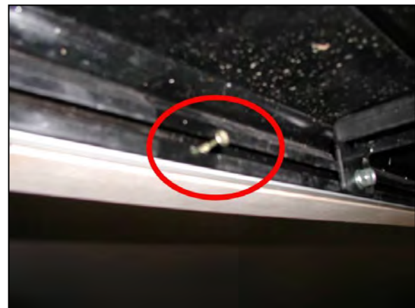
Bild 10: Schraube mittig im U-Profil Figure 10: Screw centrally arranged
